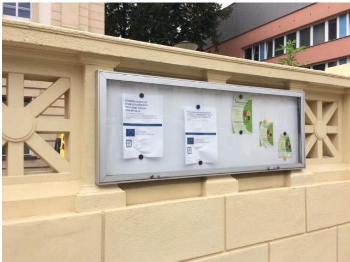
Obrázek 6.15: Nástěnka na venkovní zdi z ulice Pekařská
